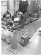
消火設備のフート弁の取換え作業
