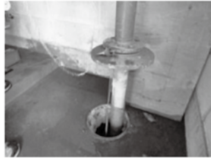
消火設備のフート弁の取換え作業
